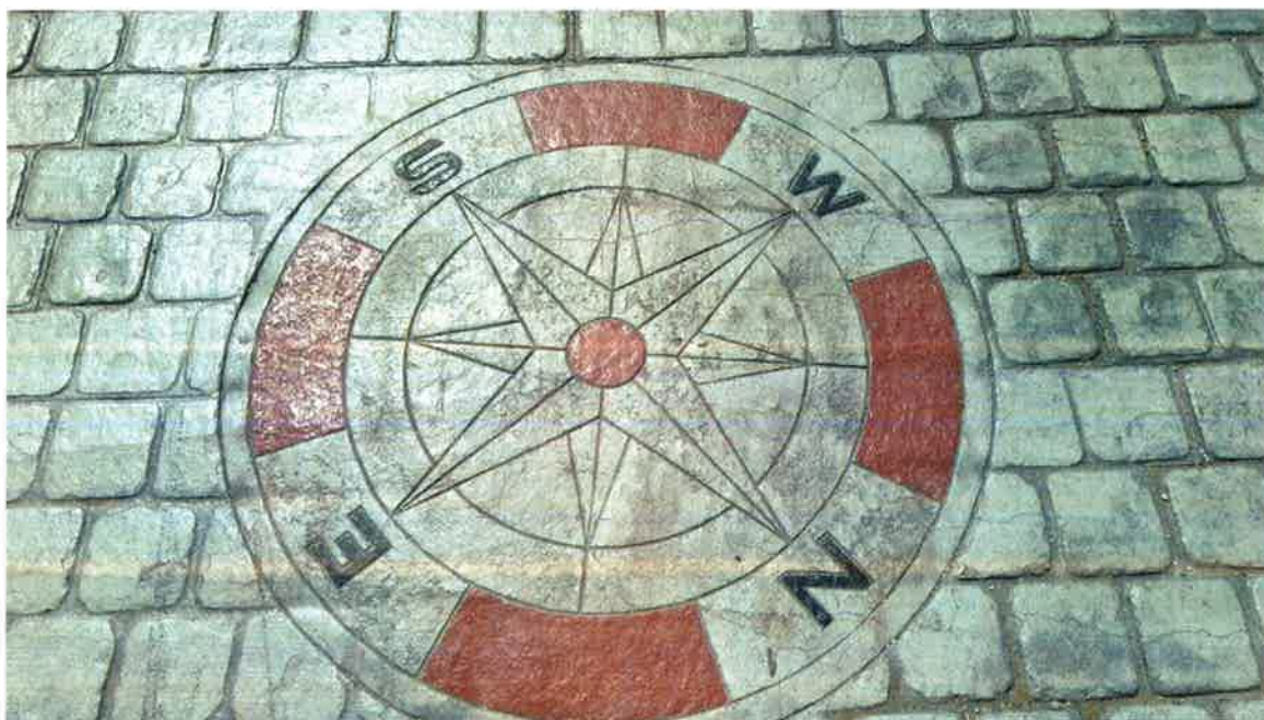
Εικόνα 7 - Διαμόρφωση σταμπωτού δαπέδου και σχηματισμός πυξίδας
