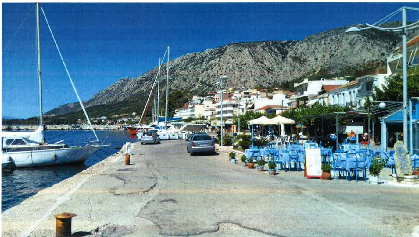
Εικόνα 1- Ανισοσταθμίες και ανομοιογένεια υλικών
